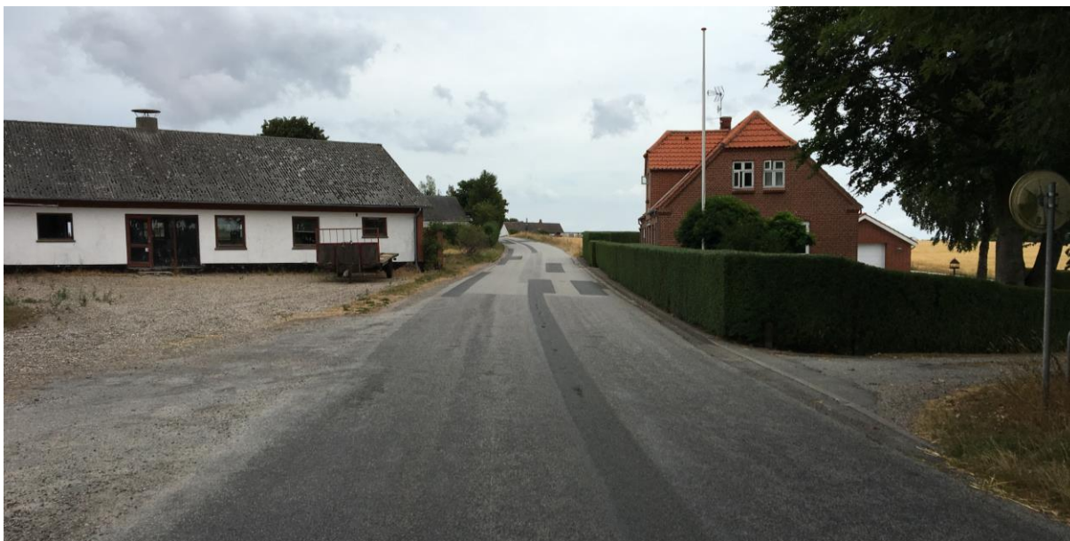
Figur 59 På strækningen l ngs Dolmervej mellem Voldby og Dolmer er der flere steder med udfordringer i forhold til at kunne etablere en dobbeltrettet cykelsti, da private ejendomme er beliggende t t p  k rebanen.
